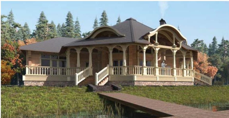
Архитектурно – конструктивные элементы этой престижной рубленой бани выполнены по мотивам деревянной архитектуры 19 века. Стены сруба рубятся из кедрового лафета толщиной 24 см. В интерьере восьмиугольной комнаты отдыха архитектурный декор более сложный с использованием резных элементов. Проектное решение позволяет объединить одной крышей различные по высоте объемы сруба и колонны каркаса галереи без установки компенсаторов.
